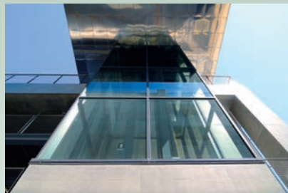
写真3 駐輪機ガラスシャフト及び格納庫見上げ
