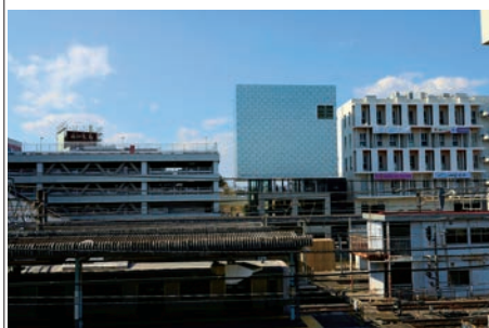
写真1 JR取手駅側からの全景
